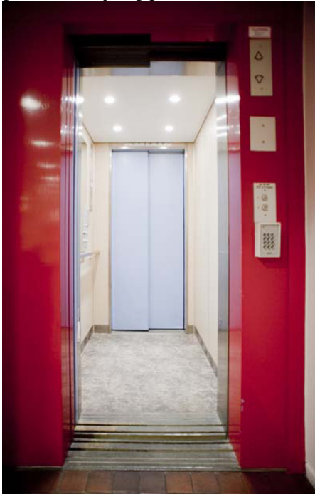
Figur 4.7. Hiss med närvarostyrd LED-belysning. Örebro Bostäder.
